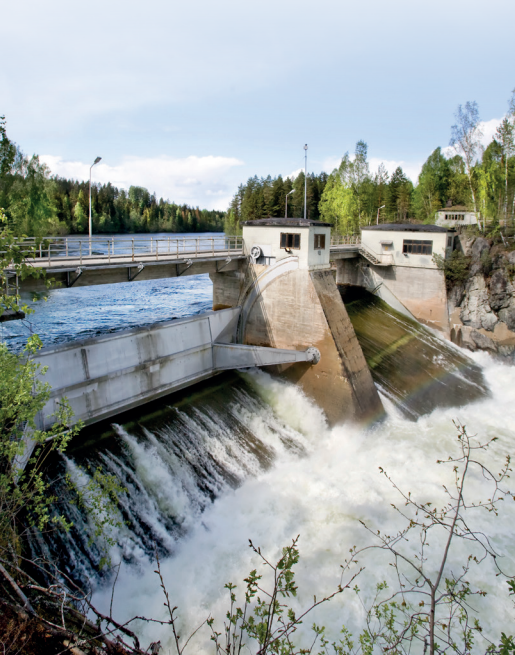
For kraftverk som ikke er ferdigstilt, skal eiendomsskattegrunnlaget svare til investert kapital 1. januar i fastsettingsåret.
